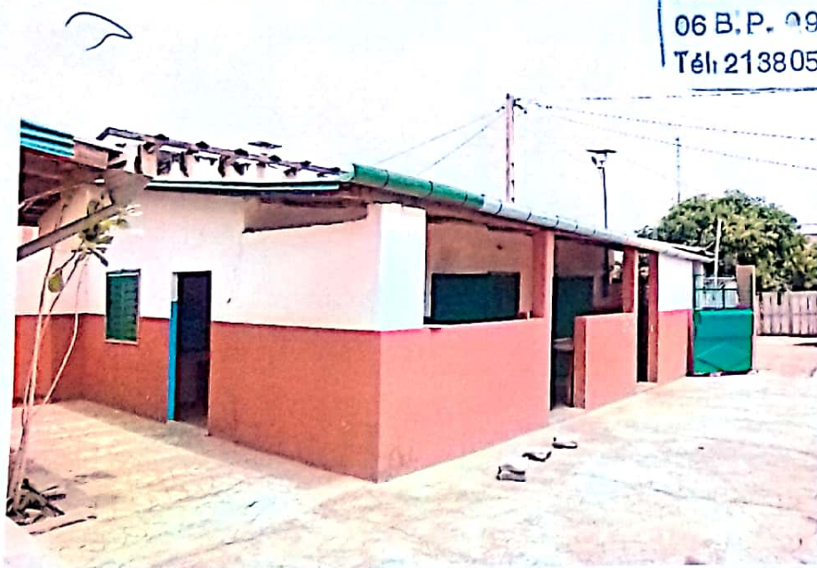
VUE SUR LE BÂTIMENT 3
