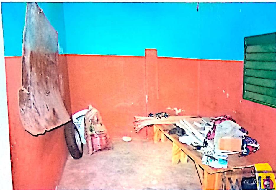
VUE SUR LA CHAMBRE / BÂTIMENT 2
